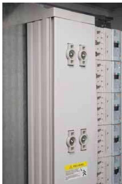
Un perfil aislante permite cubrir las barras principales de los espacios no utilizados; evitando así contactos accidentales con partes energizadas.
