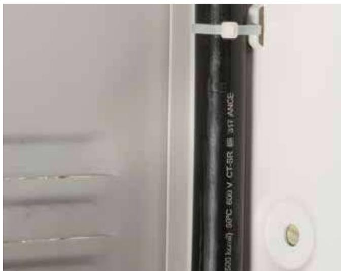
El sistema Easy fix permite la sujeción de los conductores al interior del tablero facilitando el peinado de los conductores dentro del tablero.
