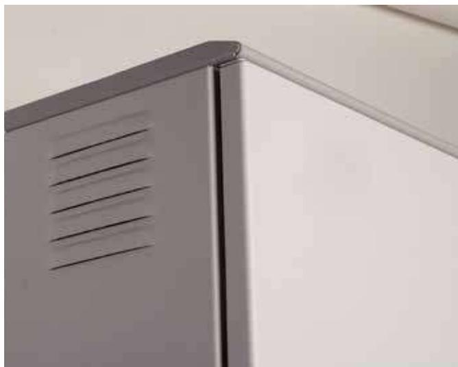
Rejillas de ventilación en ambos lados del tablero.
